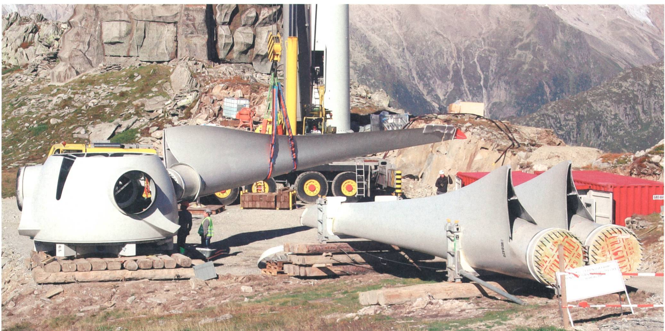
Bild 4 Montage eines Rotorblattes der neuen Windkraftanlage auf dem Gütsch.
