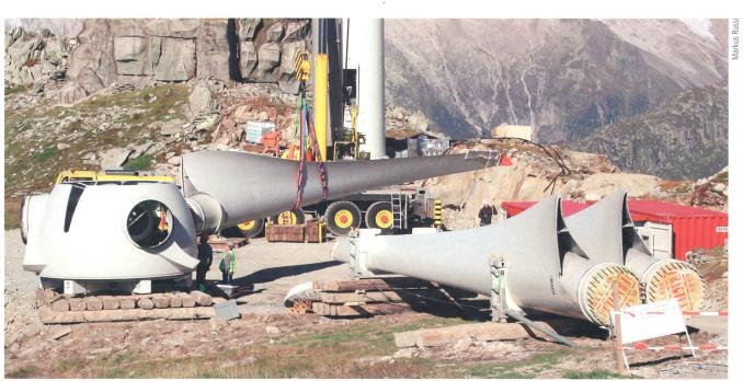
Bild 4 Montage eines Rotorblattes der neuen Windkraftanlage auf dem Gütsch.
