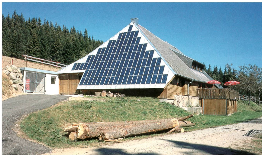
Solargenerator auf der Rappenecker Hütte im Schwarzwald.
