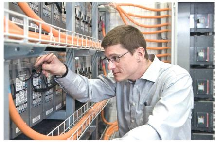
Bild 2 Batterien für die Notstromversorgung des Datenzentrums.
