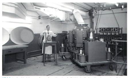
**Bild 2** Im Strahlenlabor von Brown Boveri bereitet Rolf Wideröe die Durchleuchtung eines Elektromotors vor.
