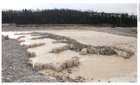
Ein Raugerinne mit den typischen quergestellten Steinblöcken, welche die Strömung bremsen. Im Hintergrund eine Kiesschnelle.
