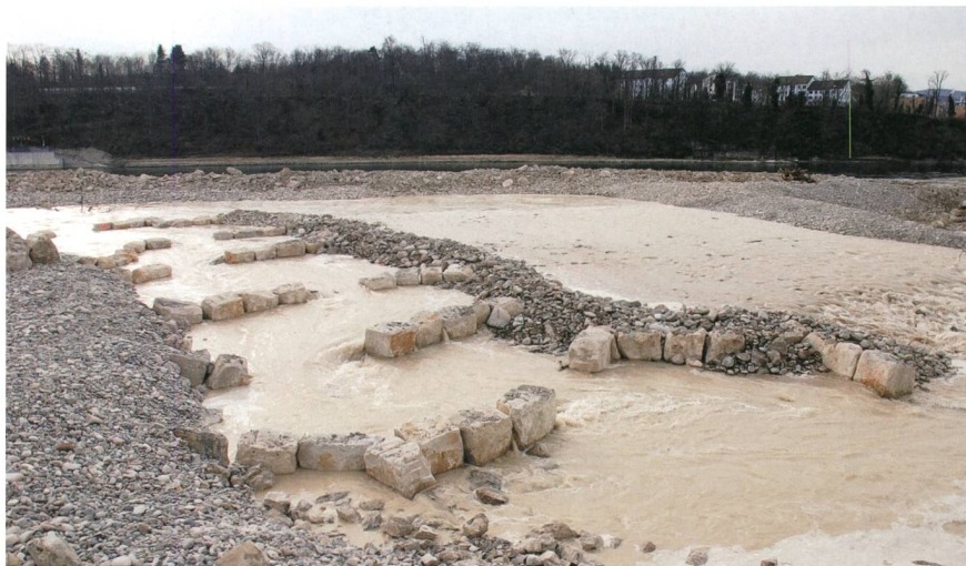
Ein Raugerinne mit den typischen quergestellten Steinblöcken, welche die Strömung bremsen. Im Hintergrund eine Kiesschnelle.
