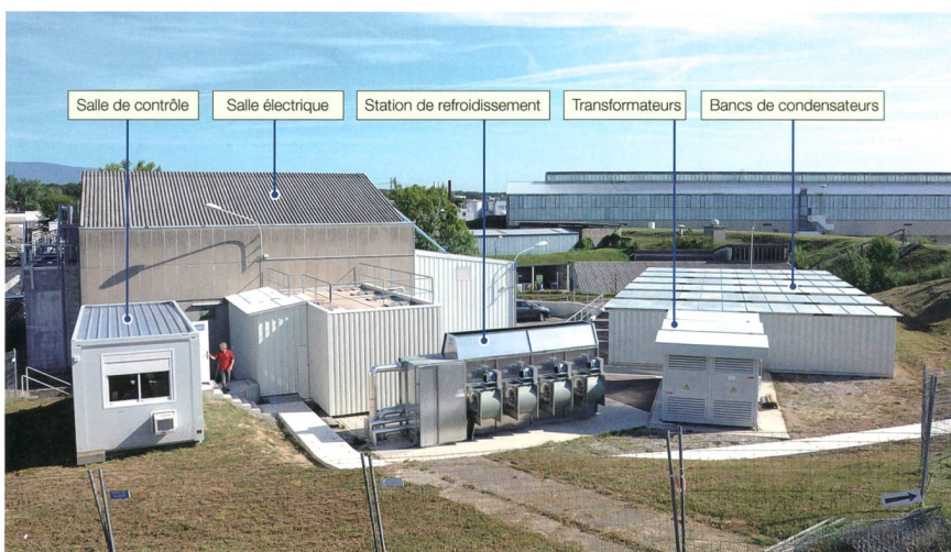
Figure 4 Nouveau système de puissance du PS installé au CERN : partie extérieure.
