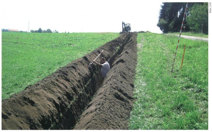
Arbeiten für die Verlegung von Kabelleitungen: Je nach Gelände und Spannungsstärke können die Kosten markant höher ausfallen als bei Freileitungen.
