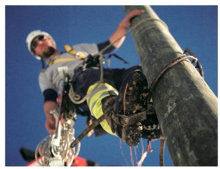
Reparaturarbeiten: Holzstangen-Freileitungen sind störungsanfälliger als Kabelleitungen.
