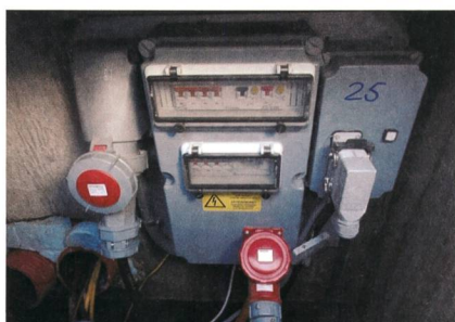
Bild 1 Unterirdischer Verteilkasten.
