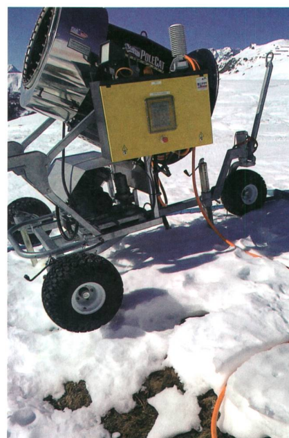
Illustration 4 Ligne d'alimentation pour canon à neige. Non conforme à la norme !
