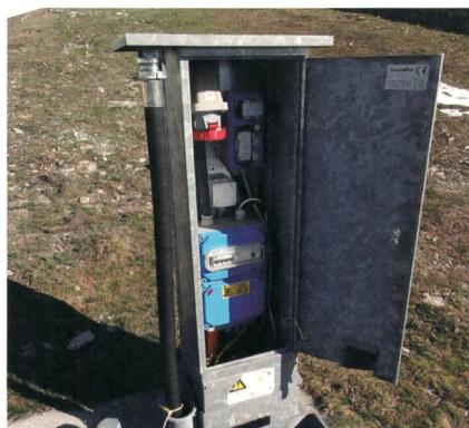
**Bild 2** Oberirdischer Verteilkasten.
