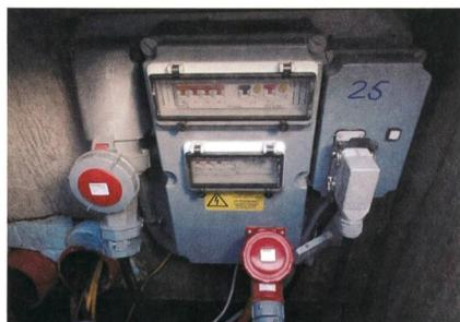
**Bild 1** Unterirdischer Verteilkasten.
