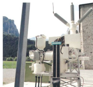
Installations de distribution électrique haute tension 170kV et 72,5kV, KWO Innertkirchen
