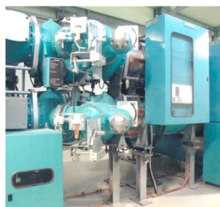
Installations de distribution électrique haute tension 170kV et 72,5kV, KWO Innertkirchen
