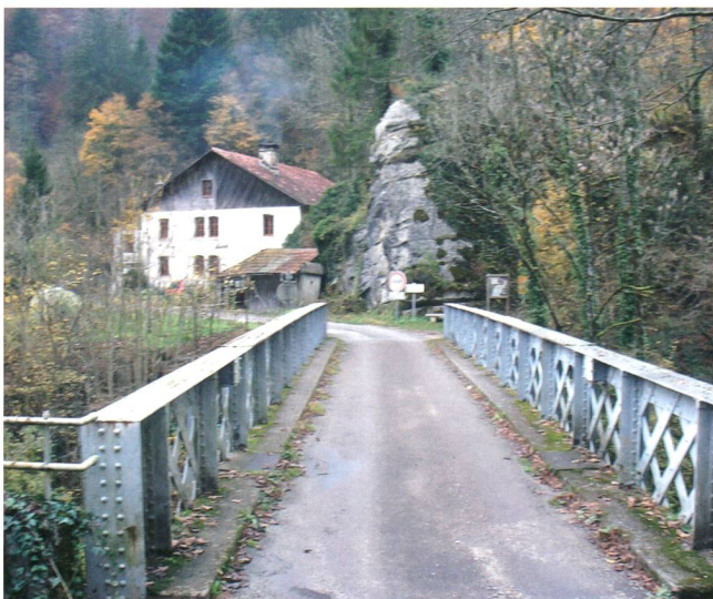
A 700 m en amont de la centrale de La Goule, ce pont permet de franchir le Doubs pour commencer la randonnée côté français.
