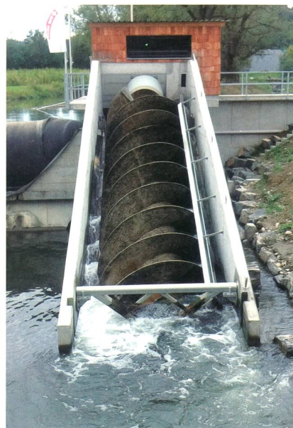
Mit einer Nennleistung von 100 kW liefert die Schraube Strom für rund 100 Haushalte.
