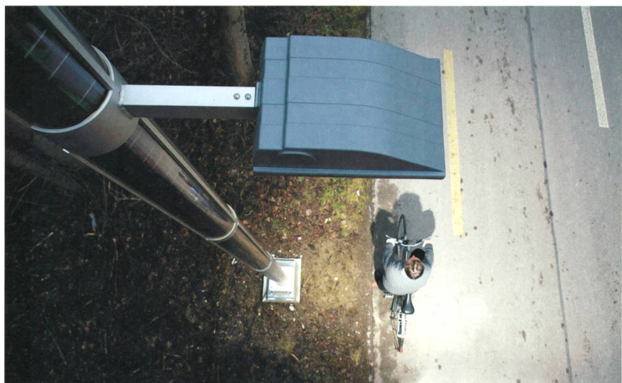
Bild 6 Ein Radweg in Aarberg: Licht wird am Tag gesammelt und in der Nacht abgegeben – eine autarke LED-Lösung mit in der Säule integrierten Fotovoltaikzellen.
