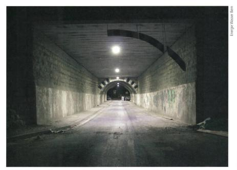
**Bild 5** Eine Unterführung wurde durch EWB mit 5 LED-Leuchten à 70 W Systemleistung ausgerüstet. Die Ausleuchtung ist hervorragend.
