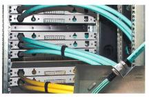
Die mit LWL-Steckern vorkonfektionierten BreakOut-Kabel lassen sich einfach verarbeiten.
