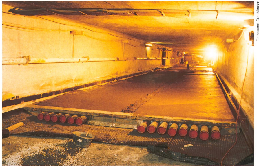
Bild 2 Kabelschutzrohre nach dem Betonieren.
