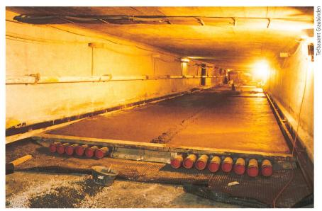
Bild 2 Kabelschutzrohre nach dem Betonieren.
