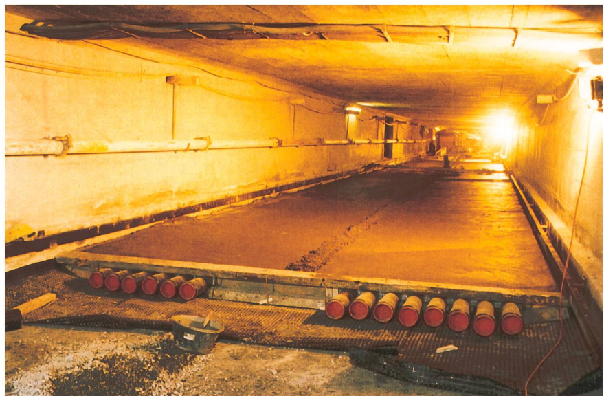
Bild 2 Kabelschutzrohre nach dem Betonieren.
