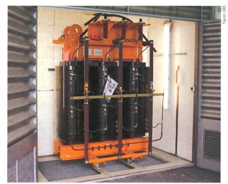
Figure 5 Transformateur amorphe EcoDry installé à ewz à Fällanden.
