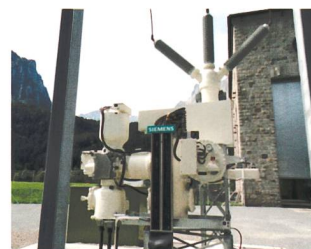
Hochspannungsschaltanlagen 170 kV und 72,5 kV, KWO Innertkirchen
