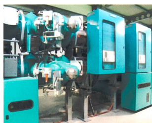
Hochspannungsschaltanlagen 170 kV und 72,5 kV, KWO Innertkirchen
