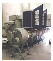
**Bild 2** In der Energiezentrale Forsthaus eingesetzte 132-kV-Schaltanlage.
