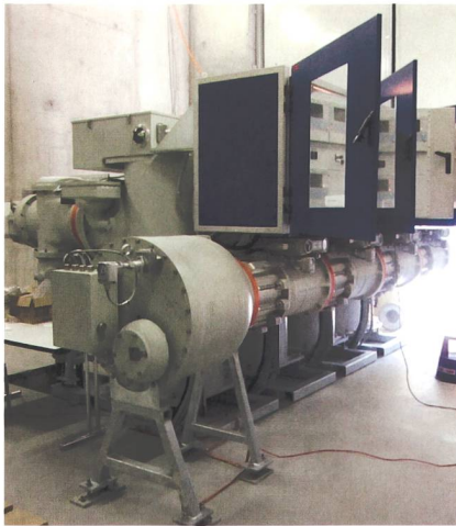
Bild 2 In der Energiezentrale Forsthaus eingesezte 132-kV-Schaltanlage.
