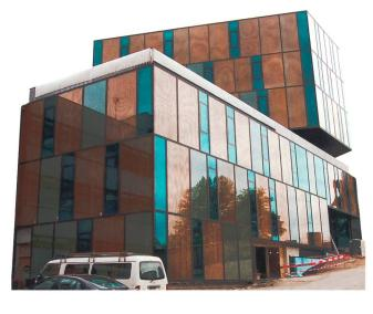
Figure 1 Nouveau bâtiment du Centre professionnel de Fribourg, entièrement vitré et à fort apport solaire passif. Différents types de vitrages sont mis en œuvre pour bénéficier au mieux de l'apport énergétique solaire.
