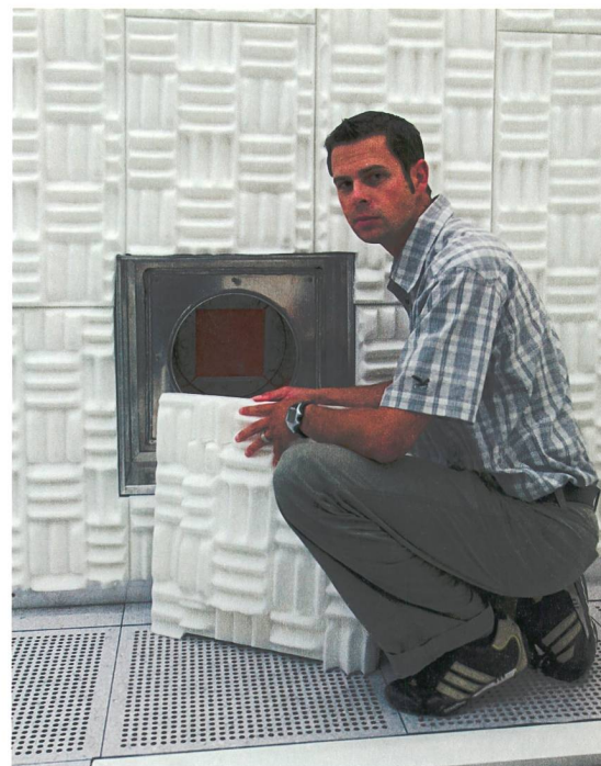
Bild 4 Eine mit schalldämmendem Material abgeschlossene Durchführung vom Experimentier- zum Hilfsbetriebsraum. Die schwingungsentkoppelte Benutzerplattform, auf der Dr. Lörtscher steht, ist an den Wänden aufgehängt.
