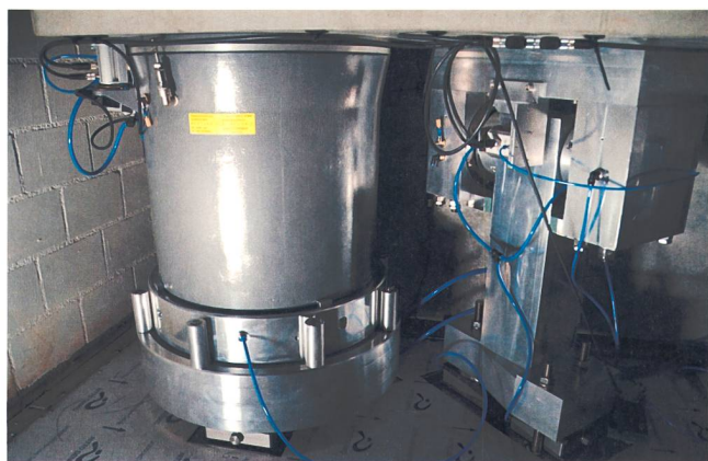
Bild 5 Luftlagerung der Betonsockel. Links ein aktiver, vertikaler Isolator von Bilz. Jeweils 4–8 solcher Isolatoren halten den zwischen 34 und 80 t schweren Sockel auf einem Luftkissen.
