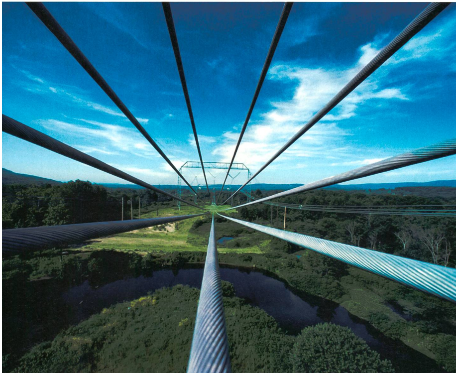
Figure 1 Les installations techniques ayant fait leurs preuves doivent relever le défi posé par l'utilisation de la technologie IT.
