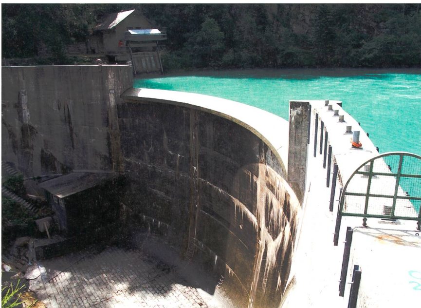
Le vieux barrage de Serra à Zwischbergen (VS) était affecté par la RAG.
