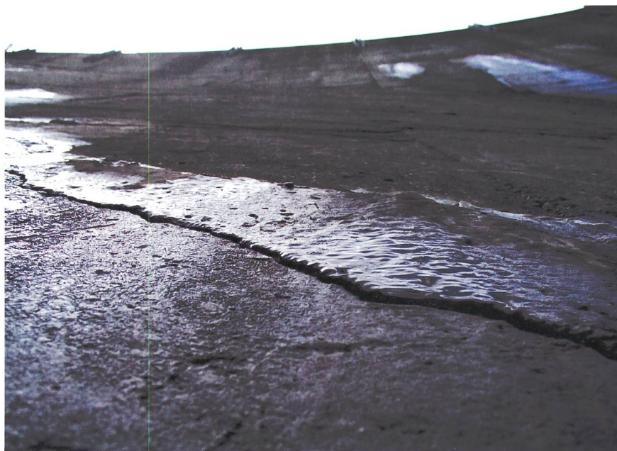
Détail d'une portion du mur du barrage de Serra attaquée par la RAG.
