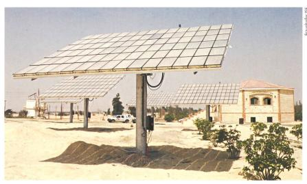
A Wadi El Natrun, en Egypte, la photovoltaïque est utilisée au lieu de groupes électrogènes diesel pour assurer l'irrigation. Un système spécial de gestion d'énergie permet un service sans batteries coûteuses.
