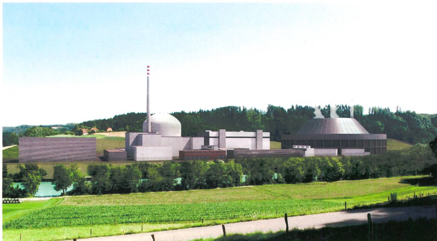
Modell des Ersatz-Kernkraftwerks Mühleberg: Über die Rahmenbewilligung soll erst entschieden werden, wenn die Sicherheitsstandards überprüft wurden.
