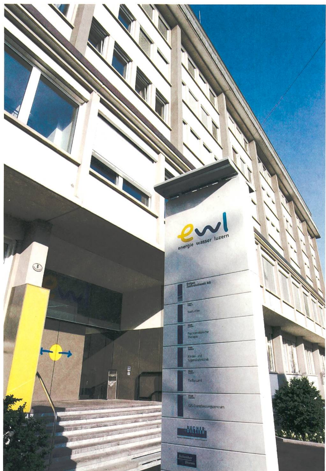
Betriebsgebäude von EWL: Die neue Software bringt Änderungen bei den Geschäftspartner- und Adressmutationen sowie beim Reporting.
