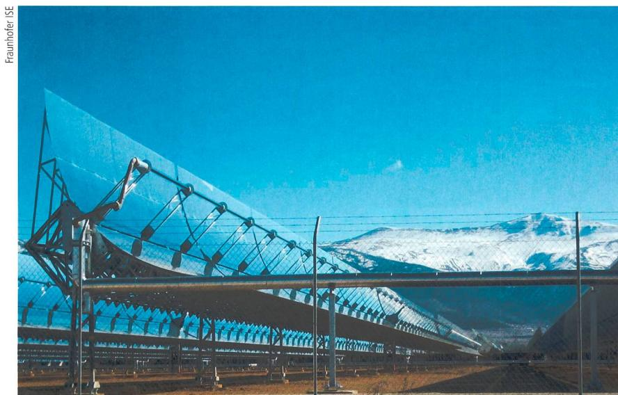
50-MW-Parabolrinnen-Grosskraftwerk im spanischen Andalusien mit Receivern und integriertem Wärmespeicher für sieben Stunden (Andasol 1).
