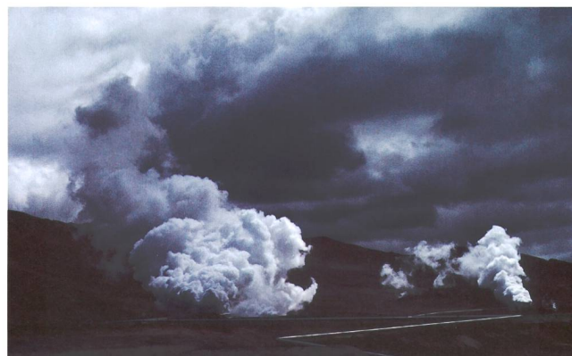
Bild 1 Geothermie-Kraftwerk in Island: Die geothermischen Kraftwerke in Island produzieren etwa einen Viertel des Strombedarfs und etwa 90% der Heizwärme und des Warmwassers aller isländischen Haushalte.
