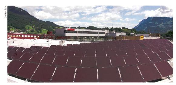
Figure 5 Microcentrale de 16 kW<sub>p</sub> (puissance maximale dans des conditions standard) installée sur le toit du bâtiment d'Oerlikon Solar à Trübbach SG. Elle est constituée de modules de silicium en couche mince de production « maison ».
