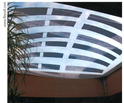
Figure 2 Cellules solaires flexibles en intégration architecturale.
