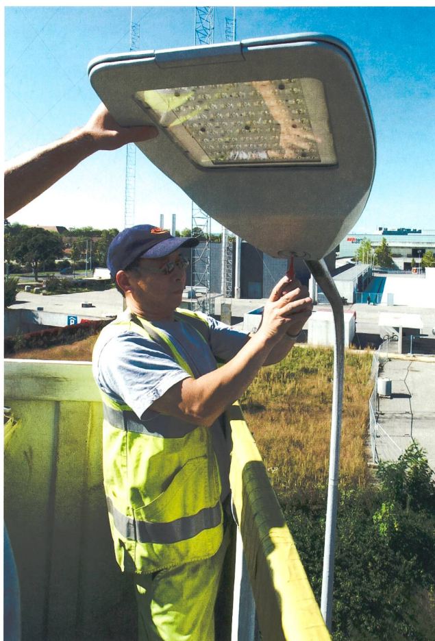
Bild 2 Montage neuer LED-Strassenleuchten an einer städtischen Verbindungsstrasse: Der Ersatz älterer Natriumdampfleuchten bringt eine Energieeinsparung von 45 %.
