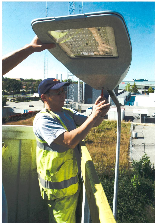
Bild 2 Montage neuer LED-Strassenleuchten an einer städtischen Verbindungsstrasse: Der Ersatz älterer Natriumdampfleuchten bringt eine Energieeinsparung von 45 %.
