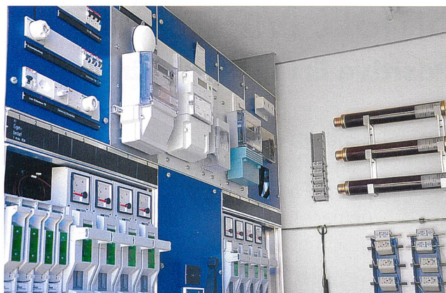
Die Datenkonzentratoren in den acht Trafostationen (hier links neben dem E350-Zähler) sammeln die Daten der Zähler.
