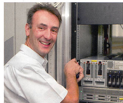
Le nouvel IBM Power 755 est installé à Lugano.
