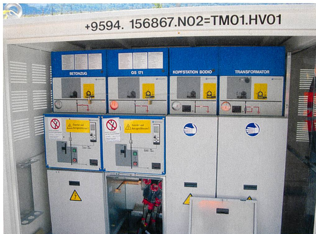
Bild 2 Trafo-Container gewährleisten die 16-kV-Stromversorgung des Betonzugs im Tunnel.
