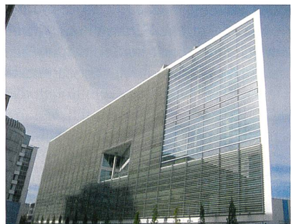
Fassadensteuerung von PentaControl für Energieeffizienz im intelligenten Gebäude.
