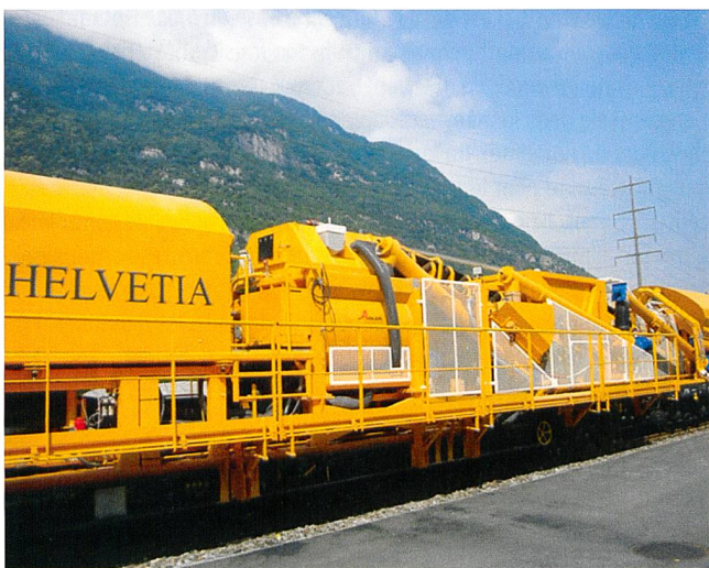
Bild 1 Betonaufbereitung vor Ort ermöglicht gleichzeitiges Arbeiten nachfolgender Gewerke im selben Einbauabschnitt.
