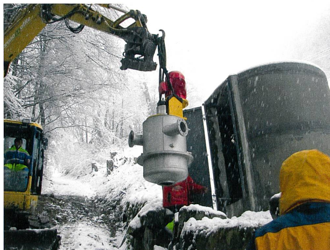
Bild 2 Einbau der Turbine in Druckbrecherschacht in Oberriet SG. Dank der kompakten Bauweise waren nur geringe bauliche Anpassungen der bestehenden Infrastruktur nötig.
