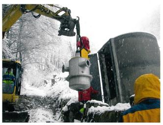
**Bild 2** Einbau der Turbine in Druckbrecherschacht in Oberriet SG. Dank der kompakten Bauweise waren nur geringe bauliche Anpassungen der bestehenden Infrastruktur nötig.
