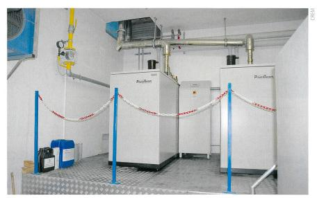
Figure 1 Couplages chaleur-force du centre de dispatching de Gaznat à Aigle.
