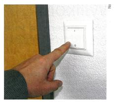
Die eingesetzten Stand-by-Stromschalter (Funkbussystem Ratio) sind batterielos.
