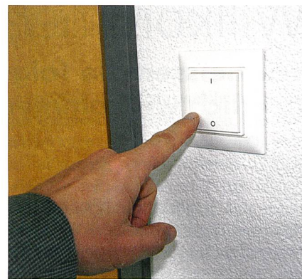
Die eingesetzten Stand-by-Stromschalter (Funkbusssystem Ratio) sind batterieless.
