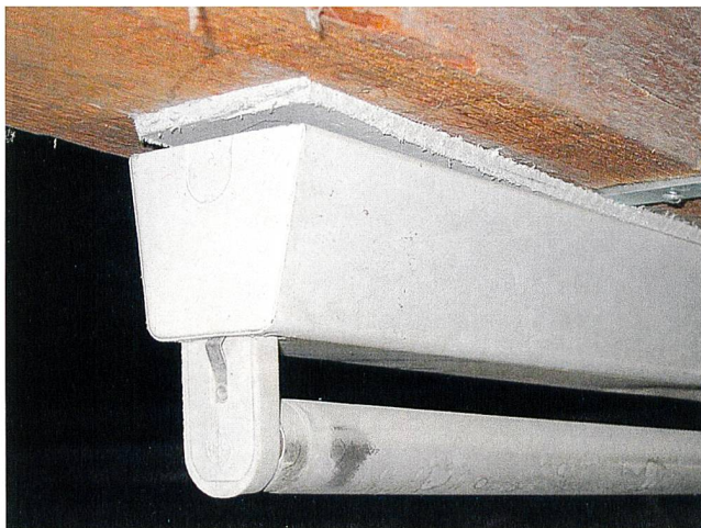
Asbesthaltige Leichtbauplatte unter FL-Armatur (schwach gebundener Asbest).
