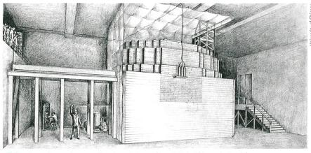
**Bild 1** Erster Kernreaktor, von Fermi am 2. Dezember 1942 in Chicago in Betrieb genommen (Chicago Pile 1). Drei unabhängige Notabschaltungsmechanismen garantierten die Sicherheit der 50 Wissenschaftler.
