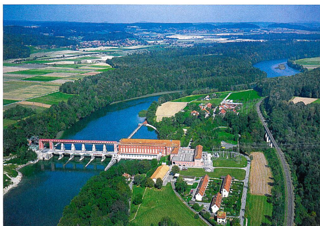
Kraftwerk Eglisau – Glattfelden.
