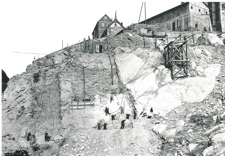
Ouvriers sur le chantier de la 1 re Dixence, mise en service en 1933.
