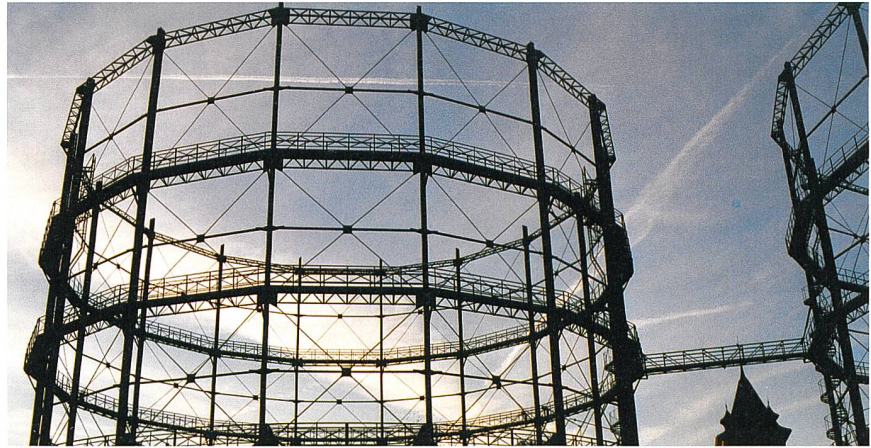
Figure 5 Le gazomètre de l'usine à gaz de Schlieren: le dernier réservoir de gaz basse pression télescopique de Suisse [23].
