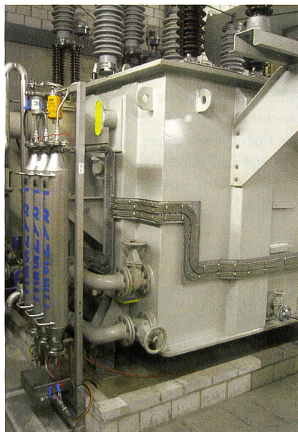
Mit stetiger Trocknung leben Trafos länger.
