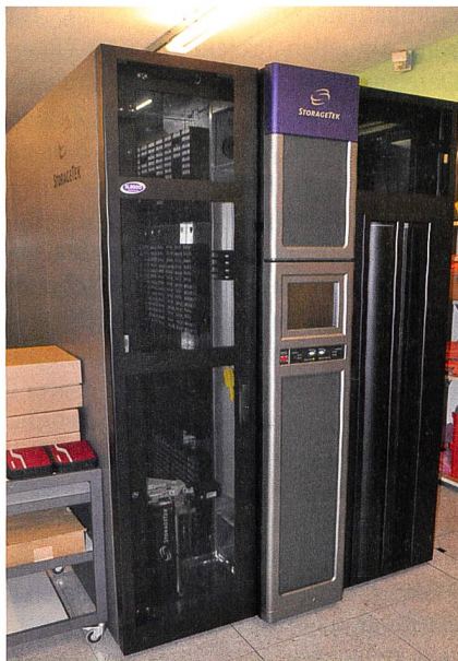
Bild 5 Das Archiv besteht aus einem Bandspeicher mit Tausenden Tapes und mehreren Laufwerken.
