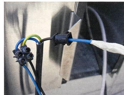
**Figura 3** A causa d'installazione erronea e dilettante una cassetta della posta illuminata è stata messa sotto tensione. Il proprietario è stato fortemente folgorato allo svuotare della tale.
