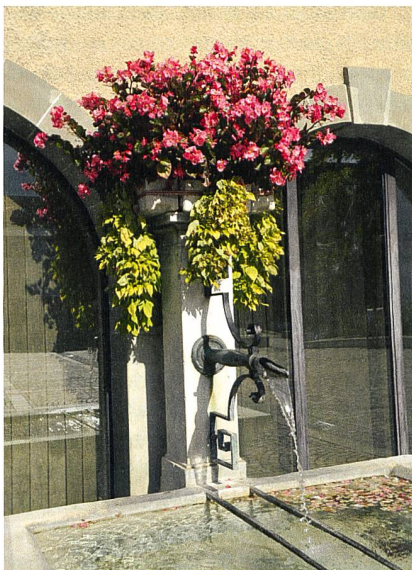
Fontaine publique: le projet «Eco-Fontaine» recycle une partie de l'eau du bassin.
