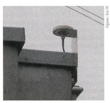
Figure 4 Antenne GPS de synchronisation.
