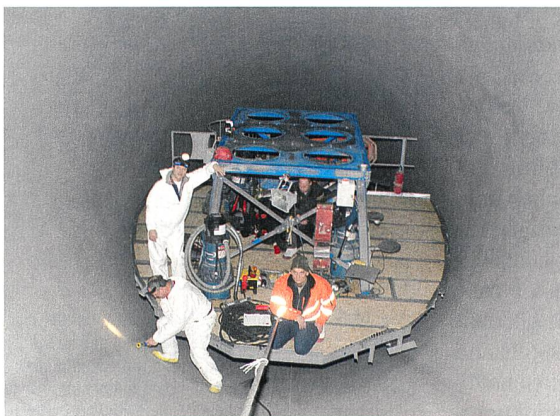
Bild 5 Sandstrahlabnahme im Druckschacht auf Befahrungsanlage, letzte Kontrolle der Reinigung (Klebebandtest) vor Freigabe zur Beschichtung.
