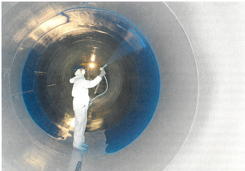
Bild 3 Applikation der zweiten Schicht Humidur in der Lindau-Überleitung.
