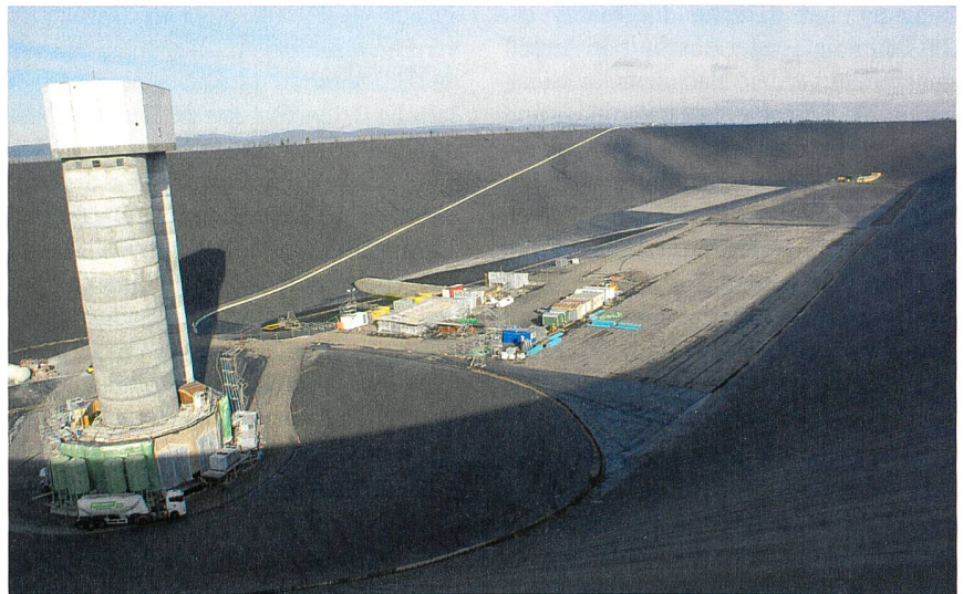
Bild 4 Speicherbecken mit Baustelleneinrichtung.
