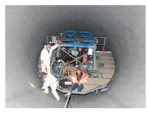
**Bild 5** Sandstrahlabnahme im Druckschacht auf Befahrungsanlage, letzte Kontrolle der Reinigung (Klebebandtest) vor Freigabe zur Beschichtung.
