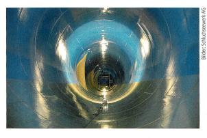
**Bild 7** Fertige Beschichtung in der Unterwasserverteilrohrleitung mit Verstärkung der Sohlund Sichelbereiche.
