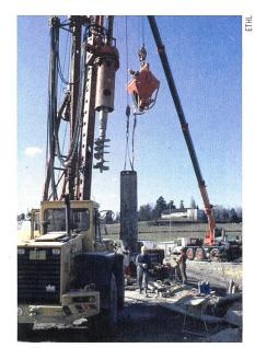
**Bild 2** Installation des als Wärmetauscher eingesetzten Fundationspfahls, ausgerüstet durch die Equipe von Professor Lyesse Laloui (ETHL).
