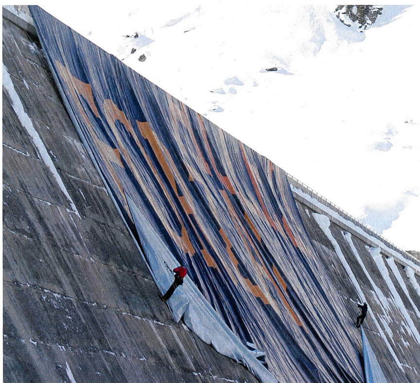
Montagearbeiten an der Staumauer des Lac de Cleuson.
