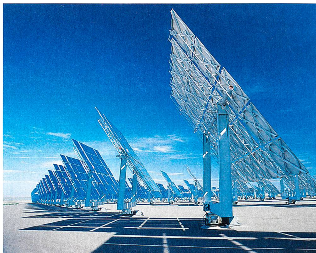
Bei grossen Solarparks folgen die beweglichen Solarmodule dem Stand der Sonne.
