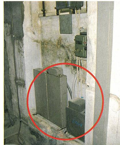
La photo montre les condensateurs de la compensation d'énergie réactive (cercle).
