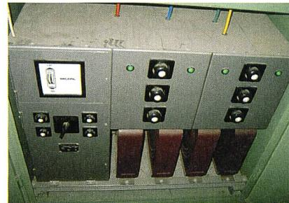
Un système de compensation d'énergie réactive avec la commande correspondante.
