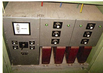
Eine Blindstrom-Kompensationsanlage mit der dazugehörigen Steuerung.
