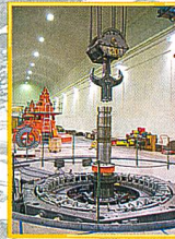
Kraftwerk-Retrofit und Neubau
