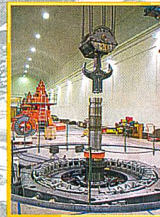
Kraftwerk-Retrofit und Neubau
